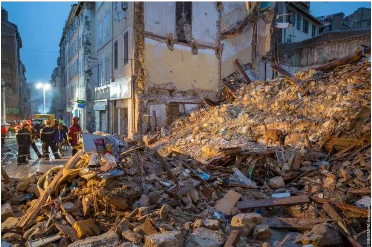
Rue d'Aubagne, après l'effondrement de 2 immeubles. Image Le Monde
