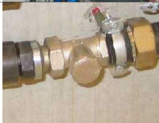
Photo 6 : exemple d'organes de réglage inadaptés à l'équilibrage d'installations d'ECS
