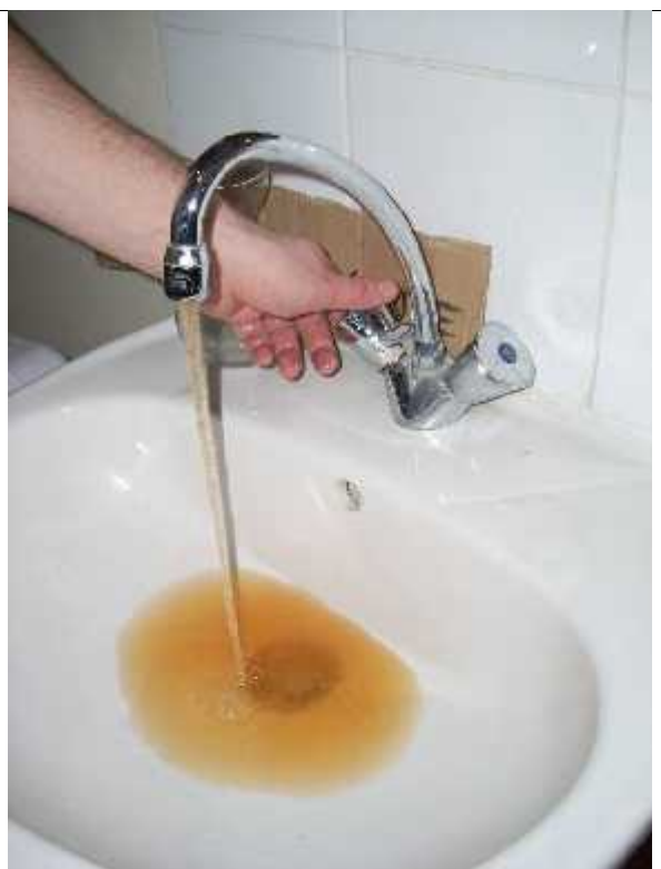
Photo 7 : Exemple de la présence de particules de fer pouvant encrasser les organes de réglage
