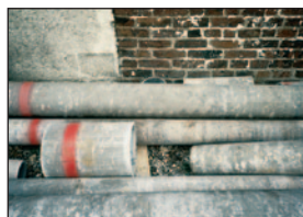
© INRS Canalisation en amiante ciment
