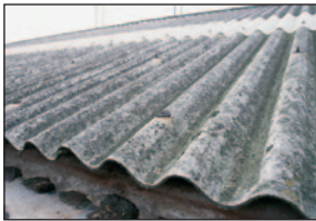
©INRS Toiture en amiante ciment
