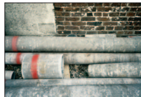
© INRS Canalisation en amiante ciment
